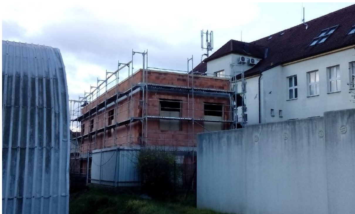
Průběh stavebních prací objektu SLNO. Foto: Archiv JU.
