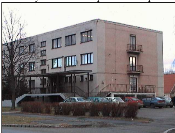
„K 200“ – špatný technický stav, nutná rekonstrukce
